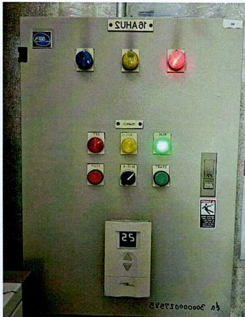
ตู้คอนโทรลแอร์ สำหรับการเปิด-ปิด
